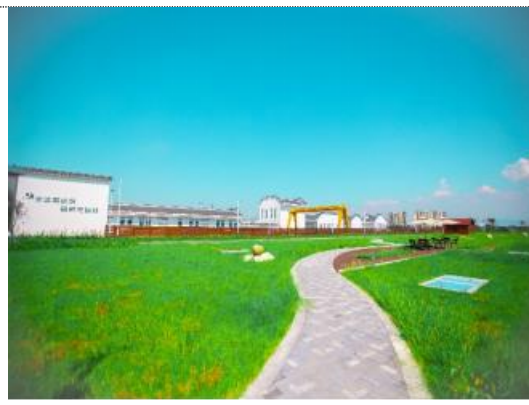
安徽望江污水处理厂项目扩建工程（5万吨/日）
