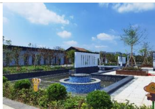
南昌市新建城地下生态水厂（2 万吨/日）
