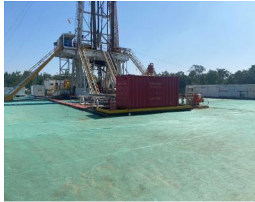
▲施工场所铺设防尘网
