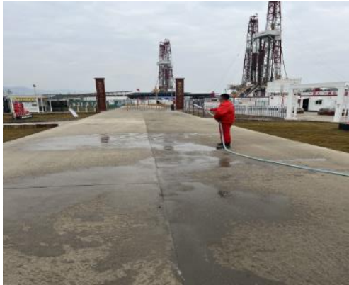
▲井场洒水降尘
