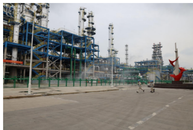
班长带两位员工抵达泄漏现场查看
