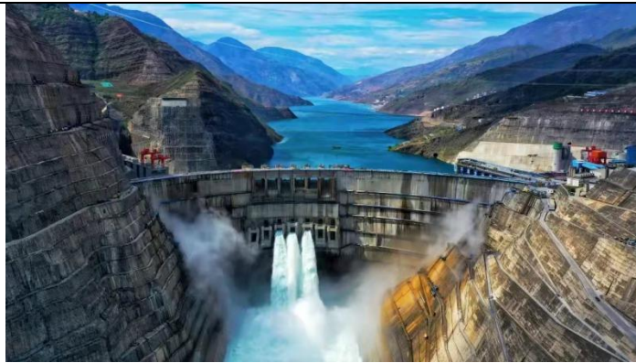
白鹤滩水电站
