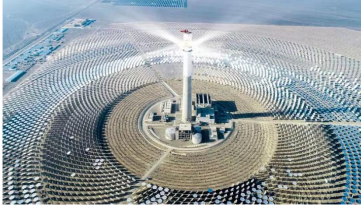
哈密熔盐塔式 5 万千瓦光热发电站
