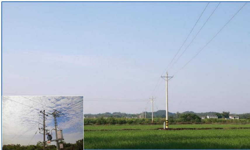
改造后的农村 10kV 线路及农村安全用电示范台区（左下）
