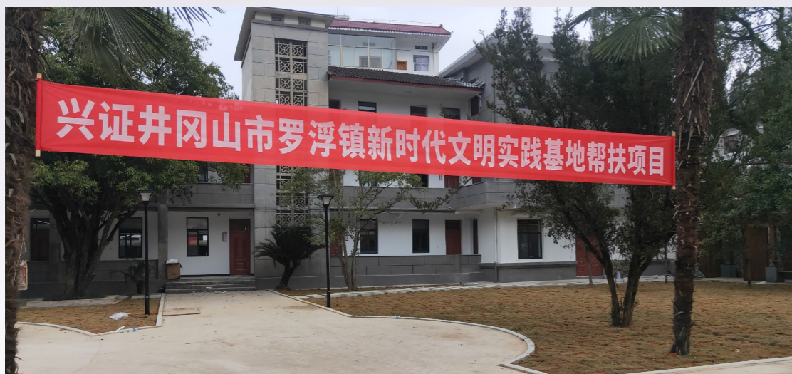
兴业证券援建井冈山市罗浮镇新时代文明实践基地
