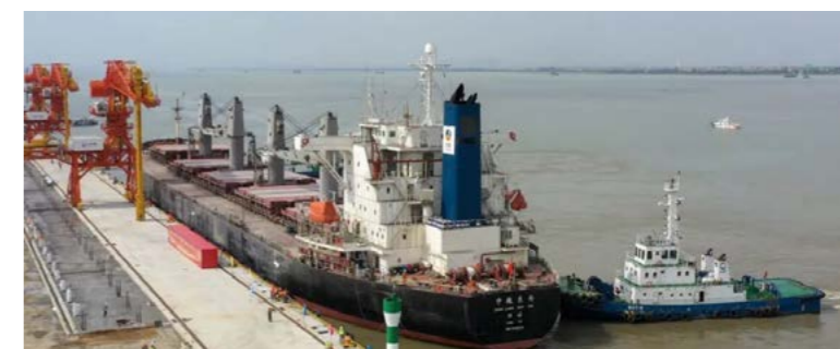
新沙二期工程试靠船成功
