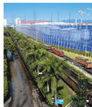
干散货码头扬尘治理，新建防风抑尘墙
