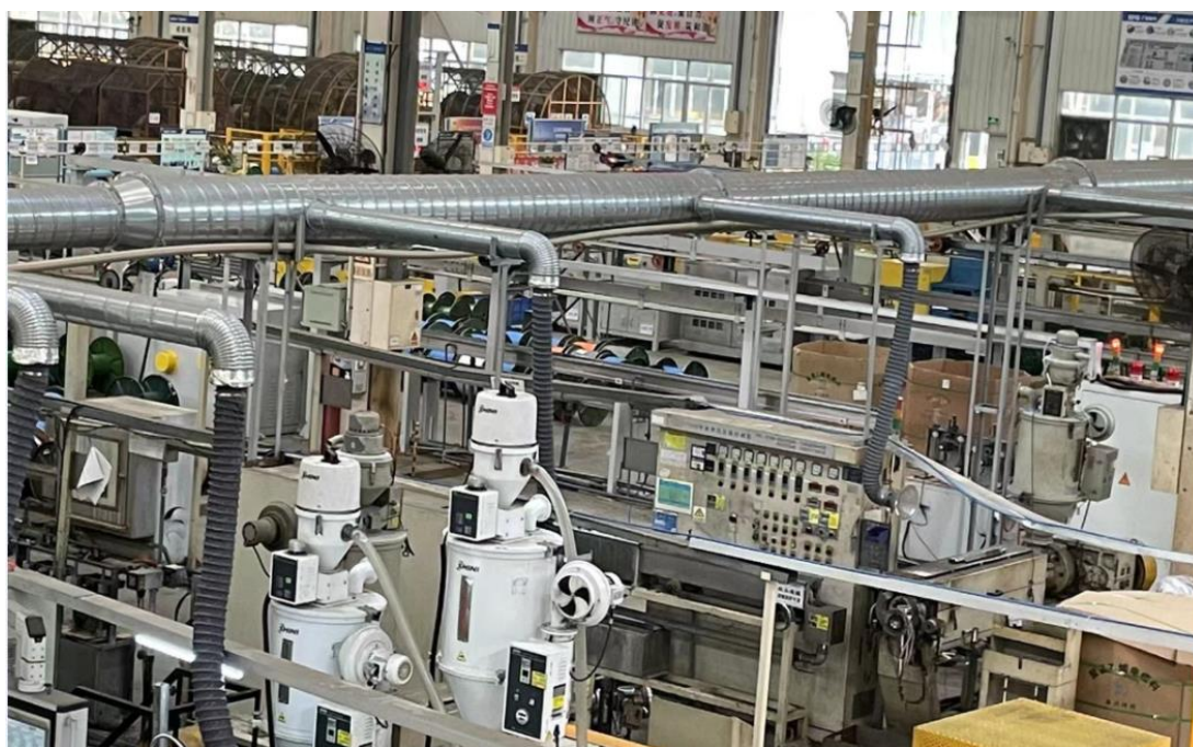
图 28 广日电气废气处理系统
