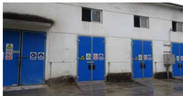
公司建立的危险废物暂存点
