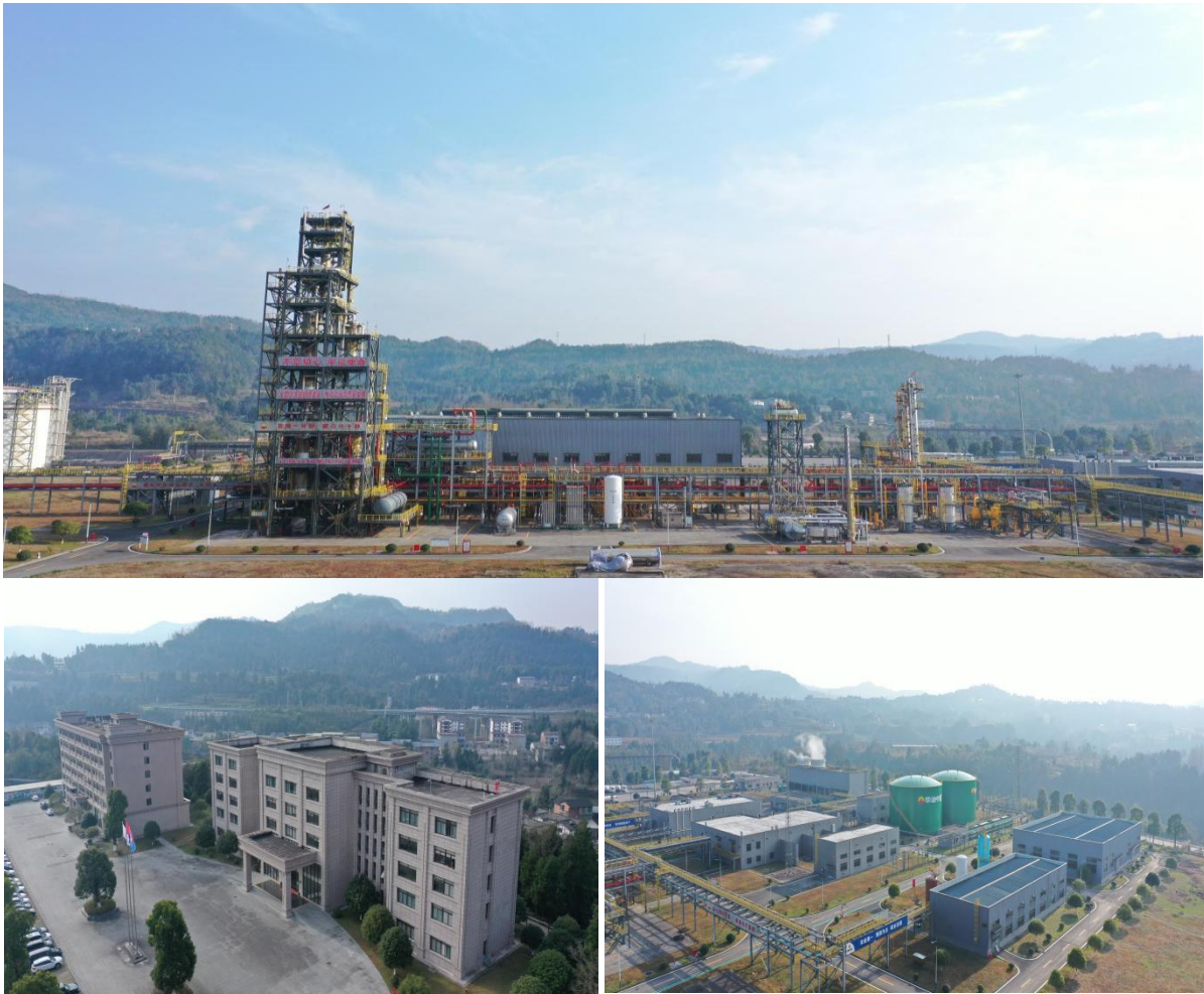
图：华油中蓝部分 LNG 生产设施及办公场所实景图
