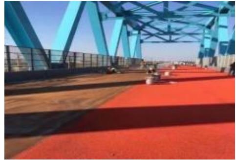
桥梁工程防水
