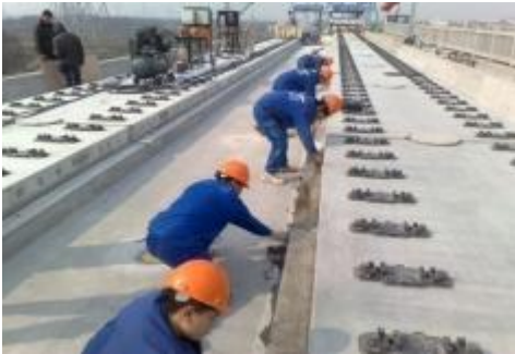
轨道建设工程施工服务
