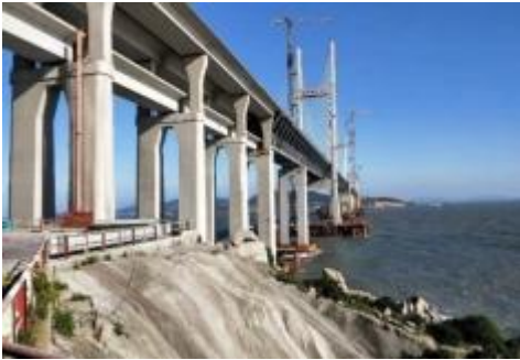
高铁混凝土桥梁防水
