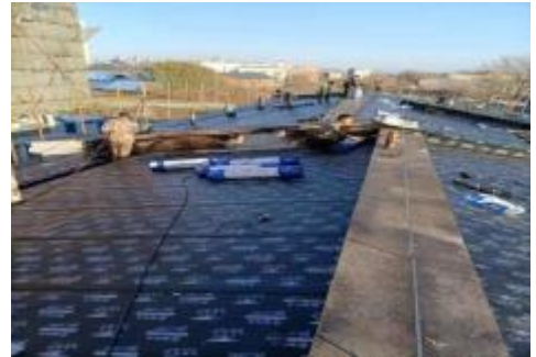
民用建筑施工服务
