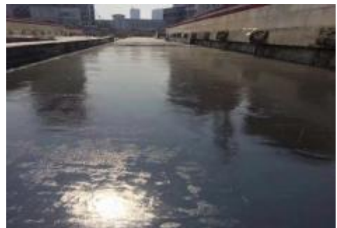
城市轨道交通工程防水
