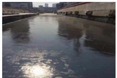
城市轨道交通工程防水
