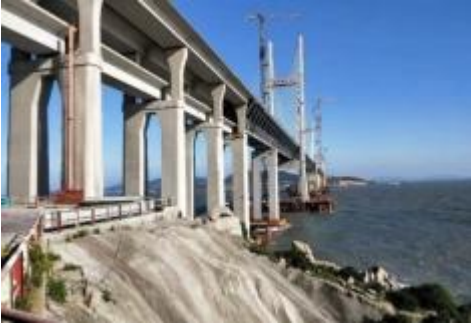
高铁混凝土桥梁防水
