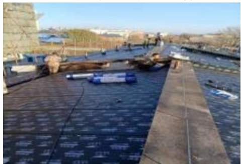
民用建筑施工服务
