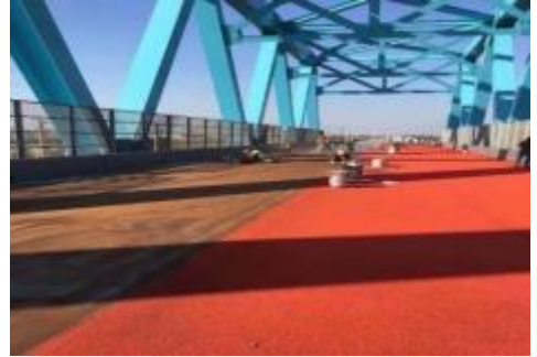
桥梁工程防水
