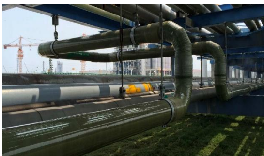
以 PP/FRP,PVC/FRP,PVDF/FRP 制成的盐酸输送管道 (尺寸: DN25-DN500)
