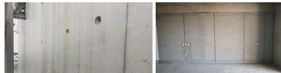
金地广州广氮项目应用全混凝土外墙 + 室内薄抹灰工艺
