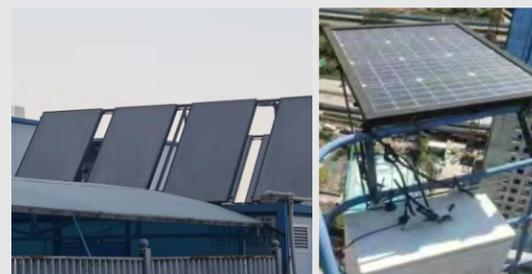
西安公司项目使用太阳能热水装置 塔吊监控太阳能电路板
