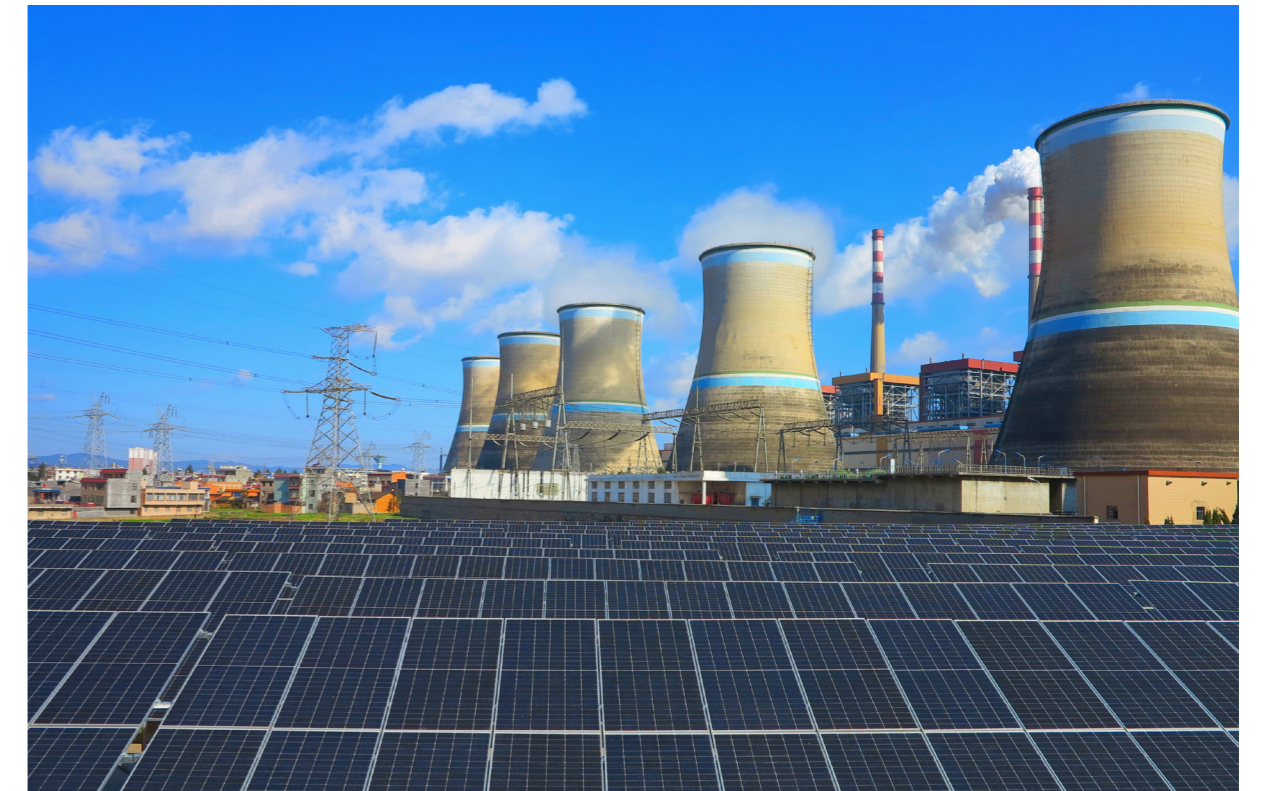
宣威公司厂区光伏项目
