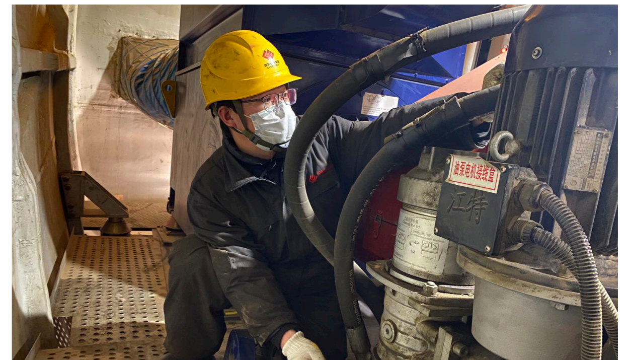
和风电放齿轮箱油准备更换齿轮箱滤芯
