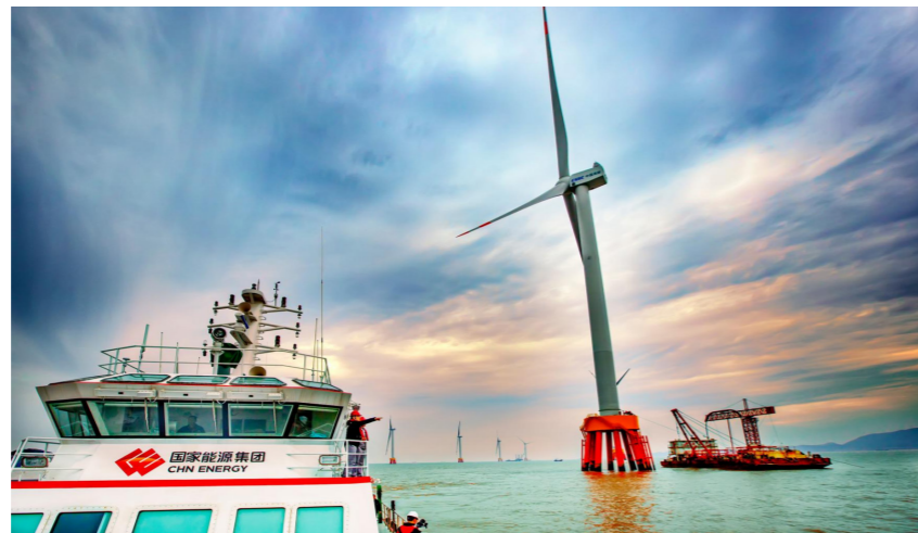
舟山海上风电象山1号项目一期工程
