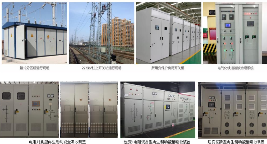
电阻能耗型再生制动能量吸收装置
