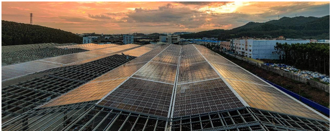
(2021 年承接全球单体最大 BIPV 江西高安建陶基地 120MW 项目，当前正在建设中)
