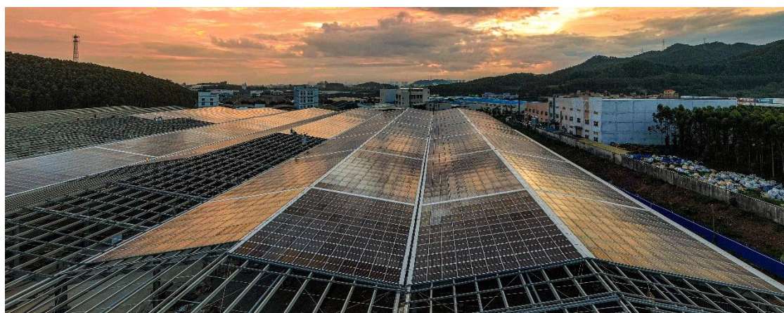
(2021 年承接全球单体最大 BIPV 江西高安建陶基地 120MW 项目,当前正在建设中)
