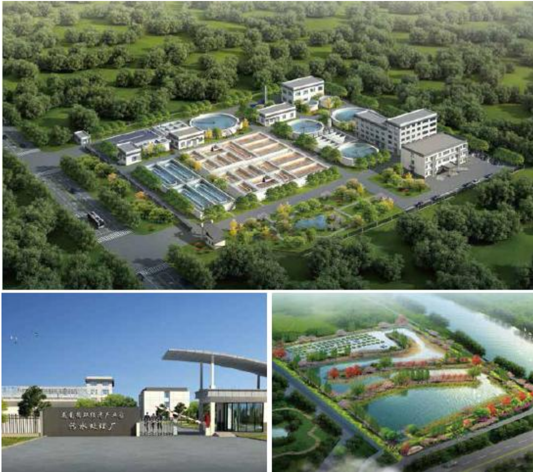
江苏兴化 戴南循环经济产业园区污水治理
