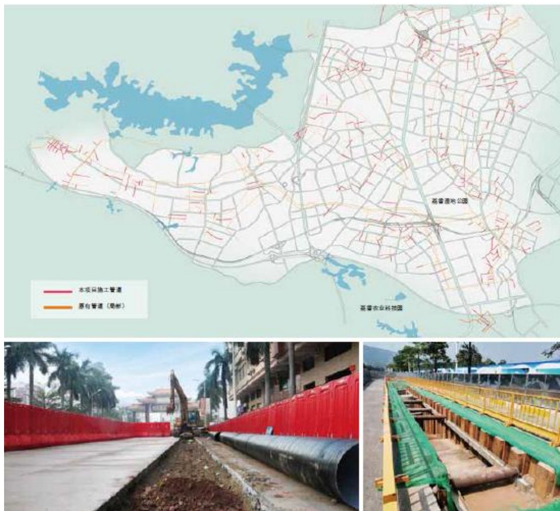
广东东莞 东引运河流域樟村断面综合治理（污水管网完善工程第四标段）
