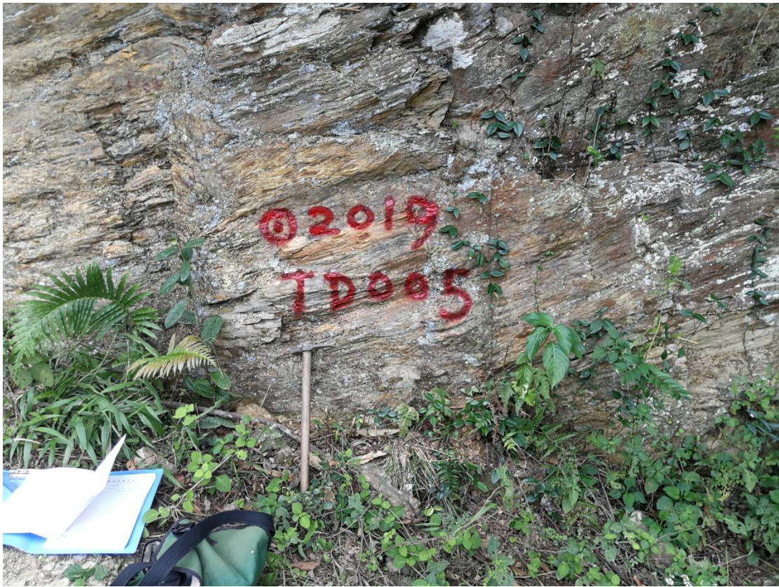
图 5、路线地质踏勘检测工程点照片
