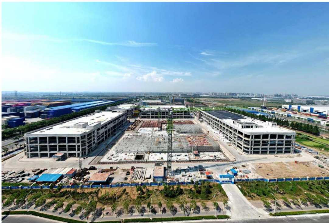
（图：中微临港产业化基地项目，摄于 2022 年 6 月）
