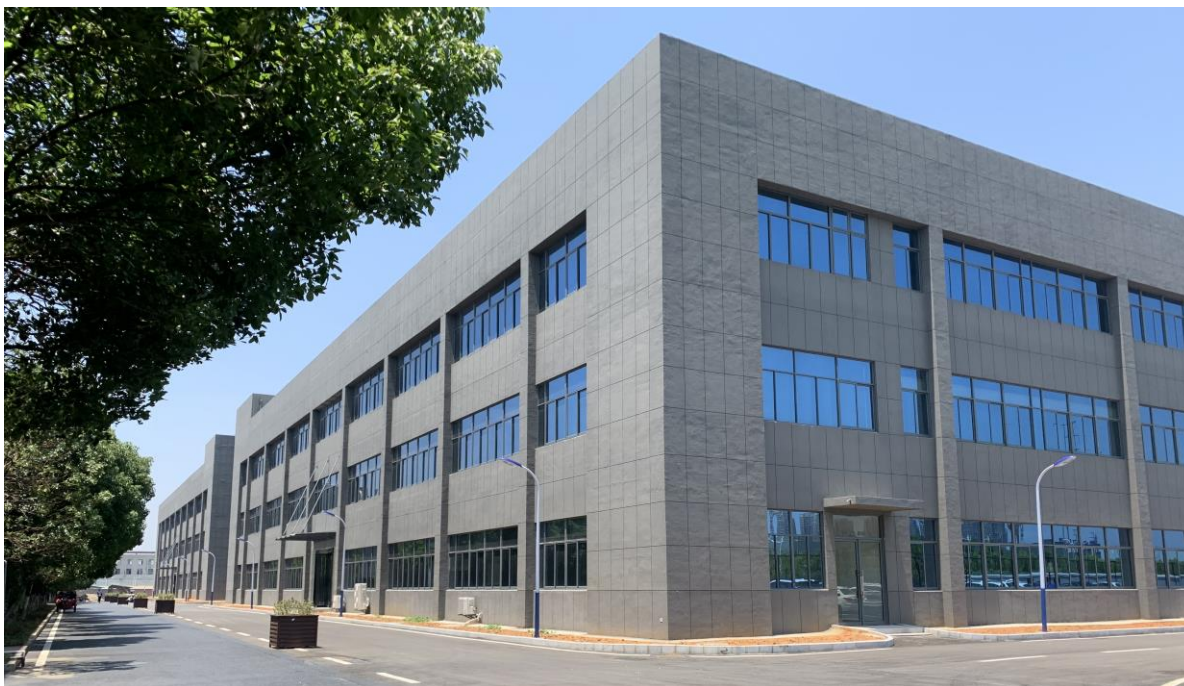
公司“年产10亿只超小型、高精度SMD石英晶体谐振器项目”生产厂房实景图片
