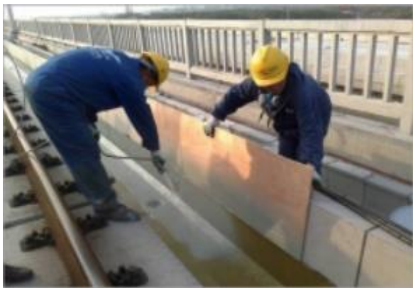
轨道建设防水
