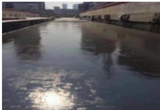
城市轨道交通工程防水
