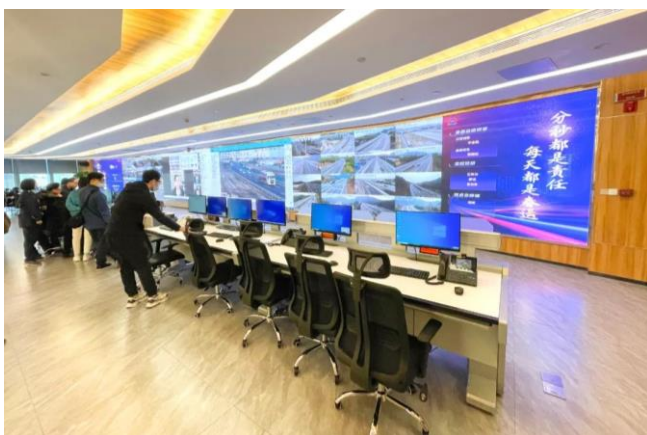
雷曼超高清大屏·广东省交通集团监控中心
