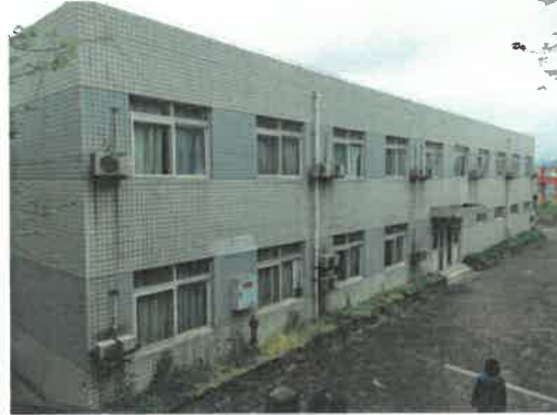
被征收的有证房屋-候工楼
