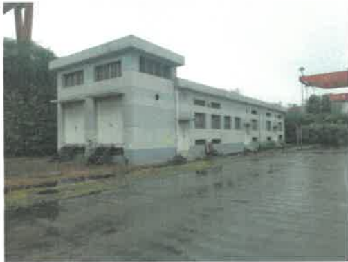
被征收的有证房屋-1号变电所
