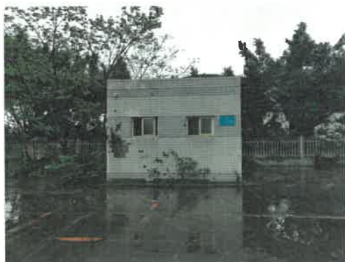
未经登记建筑-CFS 办公楼旁公厕
