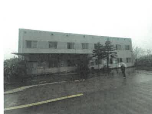
被征收的有证房屋-1号前方调度楼
