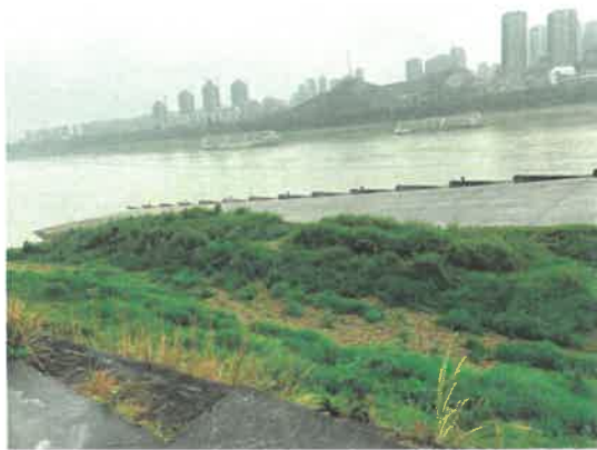
构附着物-码头及附属设施
