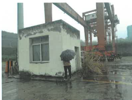
未经登记建筑-一期2平台码头管理间
