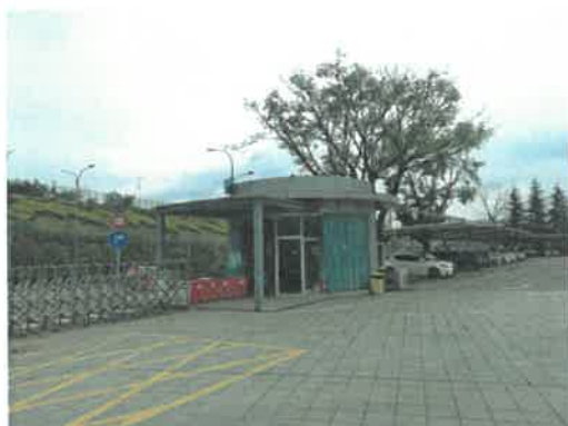
未经登记建筑-大门门卫室
