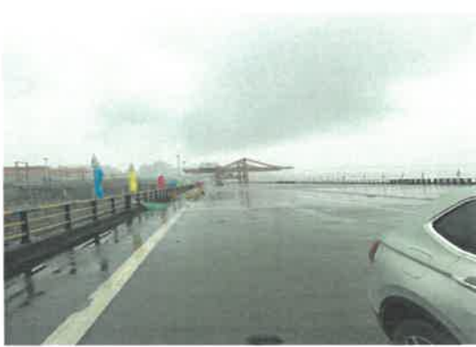
构附着物-码头及附属设施
