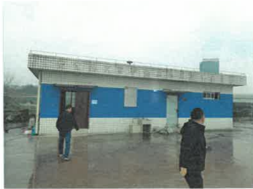
未经登记建筑(经认定为有证房屋) - 规划候工间
