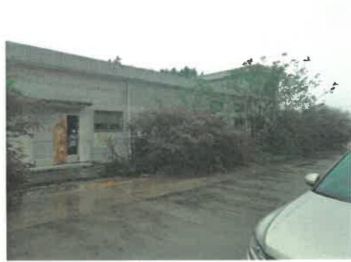
未经登记建筑(经认定为有证房屋) - 规划1#变电房
