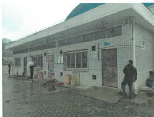
未经登记建筑-熏蒸药品库
