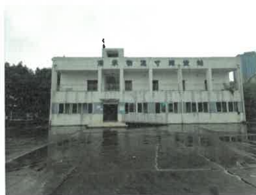
未经登记建筑-CFS 办公楼
