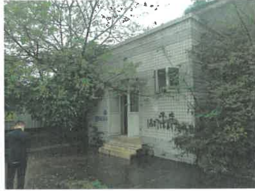
被征收的有证房屋-厕所
