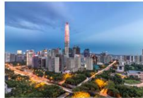
项目名称： 深圳平安金融中心 选用科顺股份材料： 蠕变型橡胶沥青防水涂料 高聚物改性沥青耐根穿刺防水卷材
