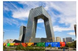
项目名称： 中央电视台新台址 选用科顺股份材料： 高聚物水泥弹性防水涂料
