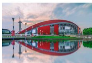
项目名称: 南京奥体中心 选用科顺股份材料: 自粘聚合物改性沥青防水卷材 丙烯酸型高聚物水泥弹性防水涂料
