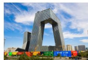
项目名称: 中央电视台新台址 选用科顺股份材料: 高聚物水泥弹性防水涂料
