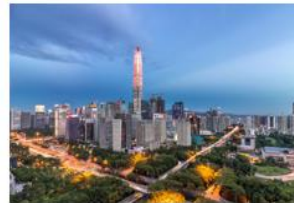
项目名称： 深圳平安金融中心 选用科顺股份材料： 蠕变型橡胶沥青防水涂料 高聚物改性沥青耐根穿刺防水卷材
