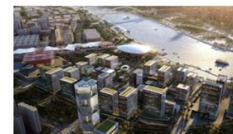
新开发银行总部大楼 工程监理、绿色建筑咨询、LEED咨询、健康建筑咨询、BIM咨询、工程检测
