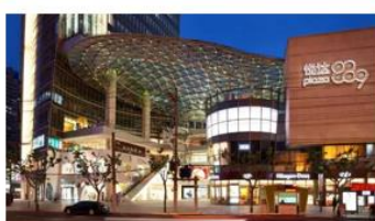
上海悦达889广场 节能改造合同能源管理
