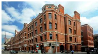
上海外滩源 房屋检测
