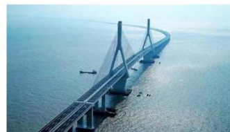
东海大桥 海工混凝土应用咨询、工程检测服务
