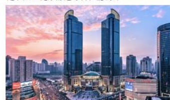
上海港汇恒隆广场 节能量核定、幕墙检测
