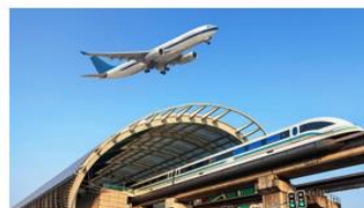
上海磁悬浮轨交 混凝土耐久性咨询、轨道梁结构静载-动载-疲劳-长期性能测试、工程监理
