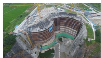
上海深坑酒店 扬尘在线监测
