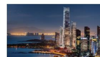
青岛海天中心 工程监理、幕墙检验、机械检测、智能化顾问等
