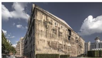
四行仓库 改造更新综合勘察与测评
