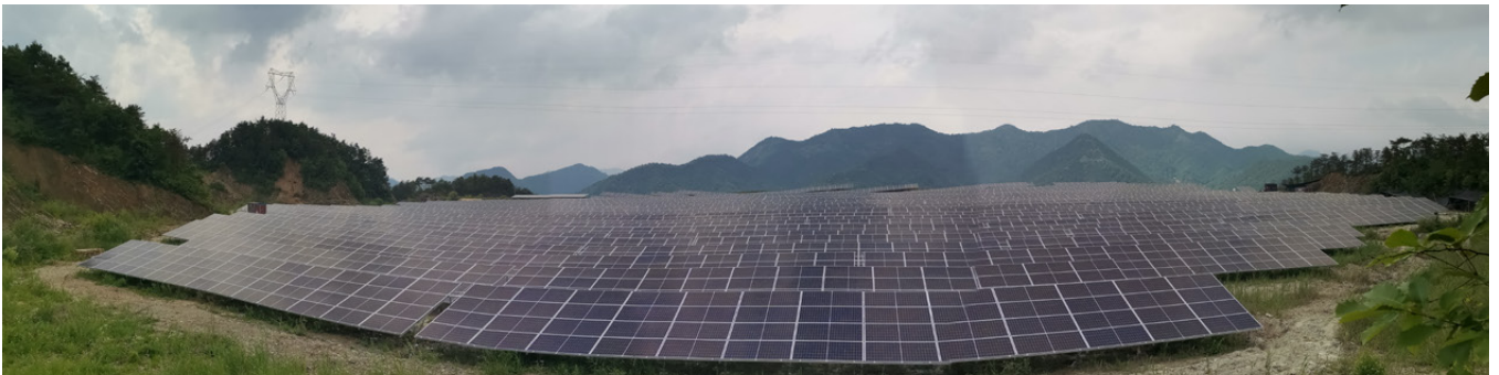
● 流水沟尾矿库光伏发电项目利用尾矿库地理优势，共安装光伏板9,000余块，完成总装机容量12兆瓦，并逐步实现并网发电，投用后预计年发电量1,987万kWh。
