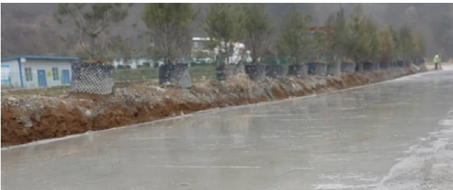
中国区利用尾矿做骨料铺设道路。
