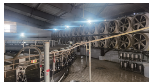
射阳牧场奶厅安装冷风机降温
