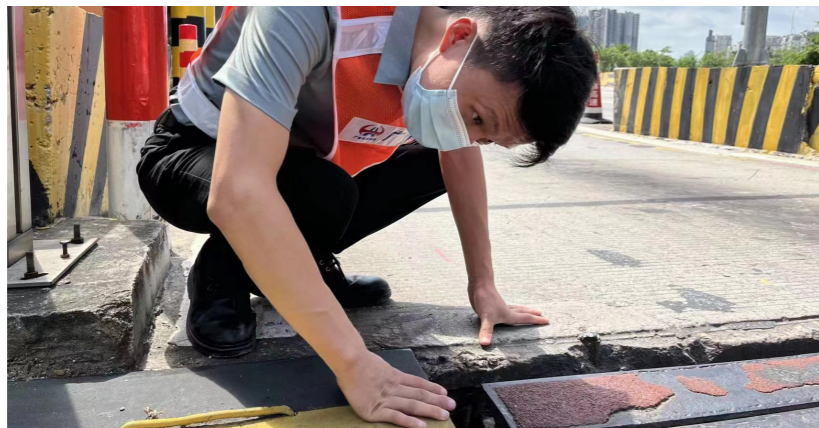
广佛高速机电组党员检查各收费站全称台基坑排水系统及基坑垃圾清理情况
