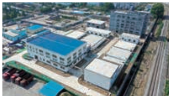
南屯煤矿高盐废水治理项目
