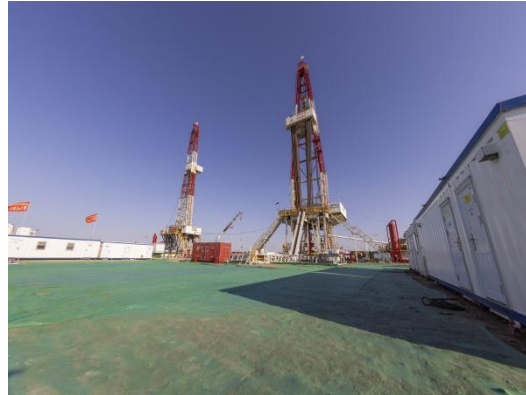
▲ 施工场所铺设防尘网
