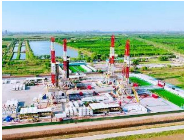
▲钻井现场泥浆清洁化处置
