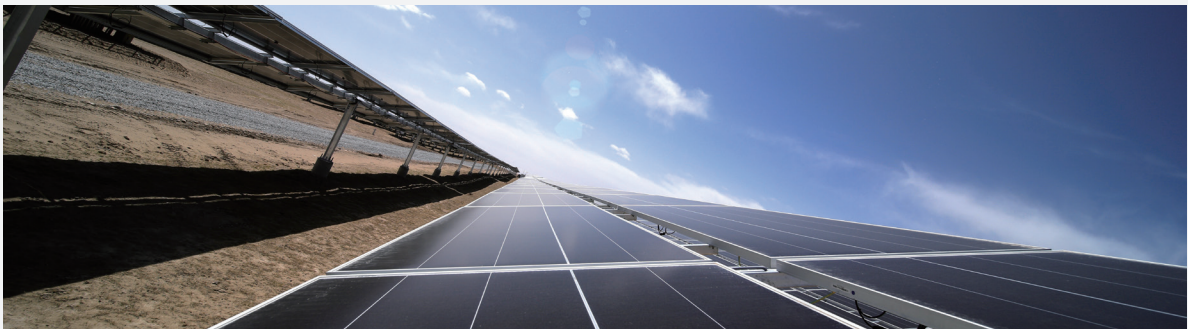
灵武马家滩光伏复合项目
