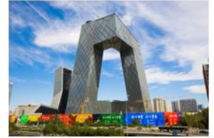
项目名称: 中央电视台新台址 选用科顺股份材料: 高聚物水泥弹性防水涂料
