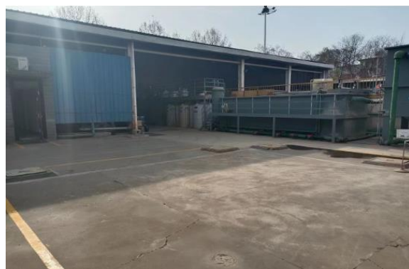
工业废水处理站
