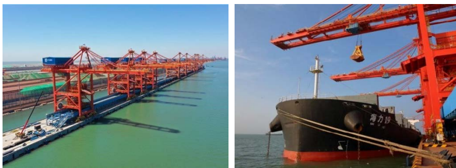
图：黄骅港区矿石码头一期续建工程
