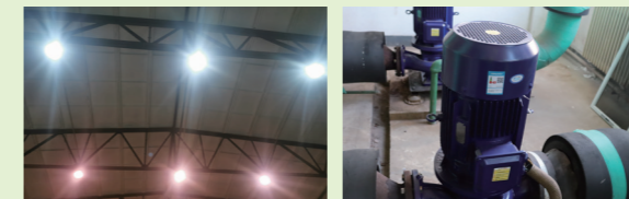
黎阳动力厂房照明节能改造 黎明公司淘汰落后机电产品
