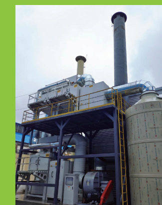
黎明公司开展挥发性有机物治理
