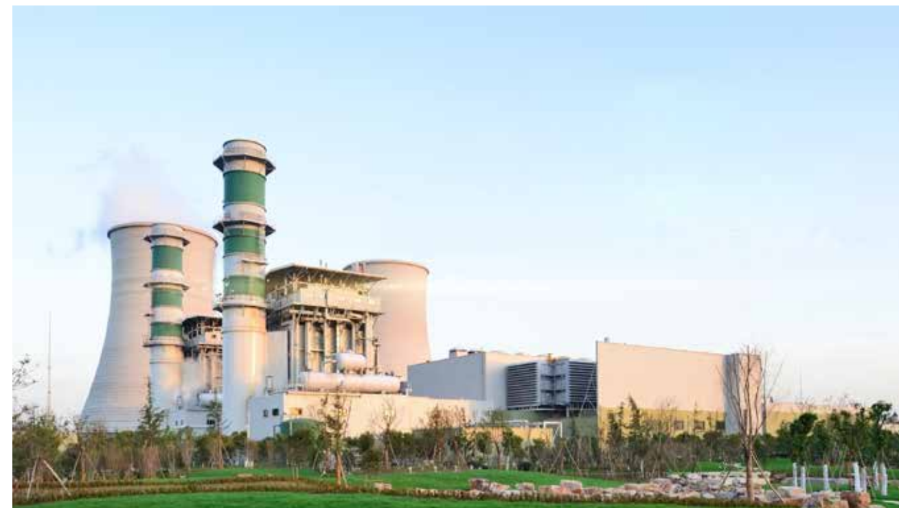
打造“花园式”燃机电厂，提升生态环保治理水平
