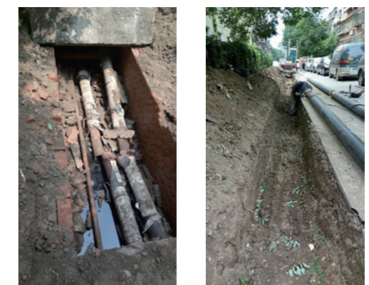
—直埋管道改造前后对比图—
