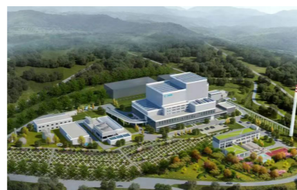
重庆市奉节县环保能源发电厂项目
