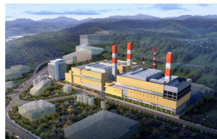
澳门垃圾焚烧中心第三期扩建项目
