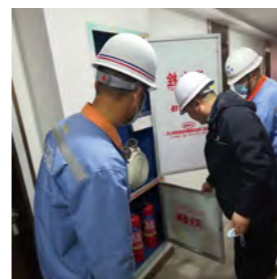
■ 安全风险隐患大排查现场
