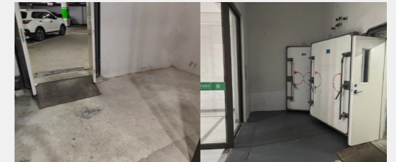
肇庆新城香悦公馆地下室入口改造
