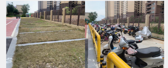
恩平新城香悦公馆园区路面改造
