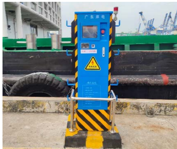
▲ 南沙集装箱码头分公司岸电插座箱
