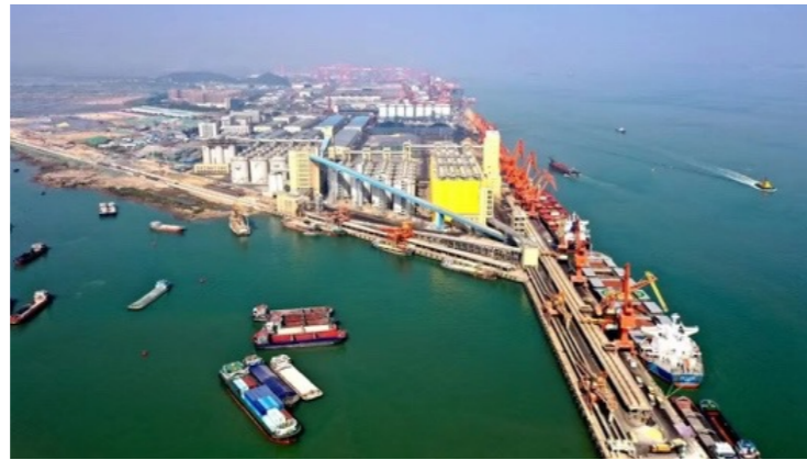
▲ 南沙粮食通用码头扩建工程
