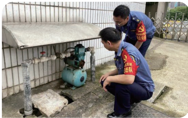
支部人员修理水管渗水、漏水问题
