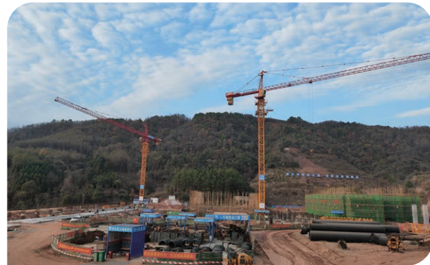
在建怀化生活垃圾焚烧发电项目
