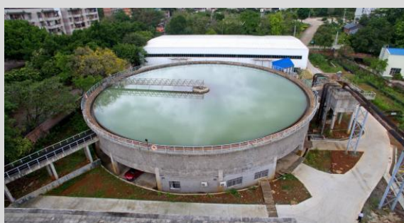
凡口矿井下水澄清处理系统辐流式沉淀池
