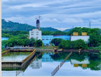
韶关冶炼厂废水零排放系统 4.3 万 m 3 雨水收集池
