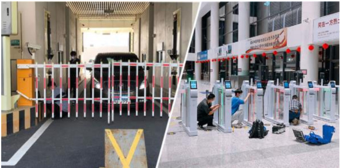
公司工程师在福田口岸、莲塘口岸紧急安装调试设备
