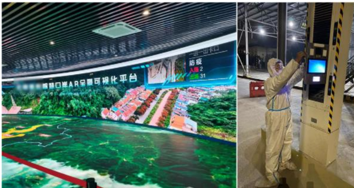
公司工程师在云南磨憨陆路口岸安装调试通关新设备
