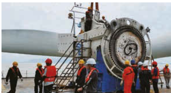
风机齿轮箱更换检查
