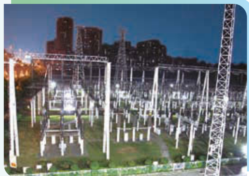
罗涌变电站LED照明节能改造
