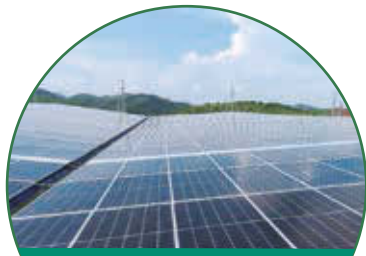
广西新舵陶瓷有限公司 一期屋顶分布式 光伏发电项目
